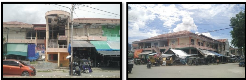
Gambar 1. 1 Tampilan Bangunan sentral terlihat kumuh (sumber: Hasil survey, 2019)
