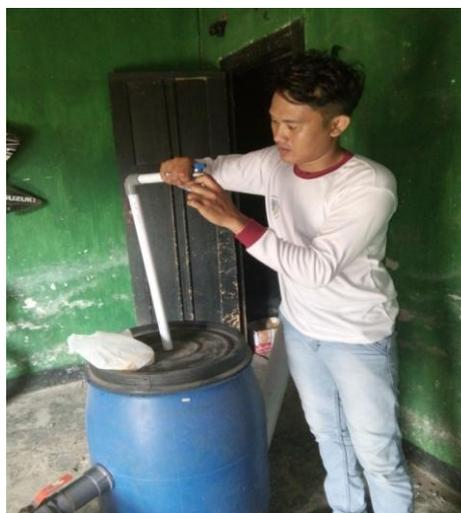
Gambar 3.10. *Pemasangan kran gas*
