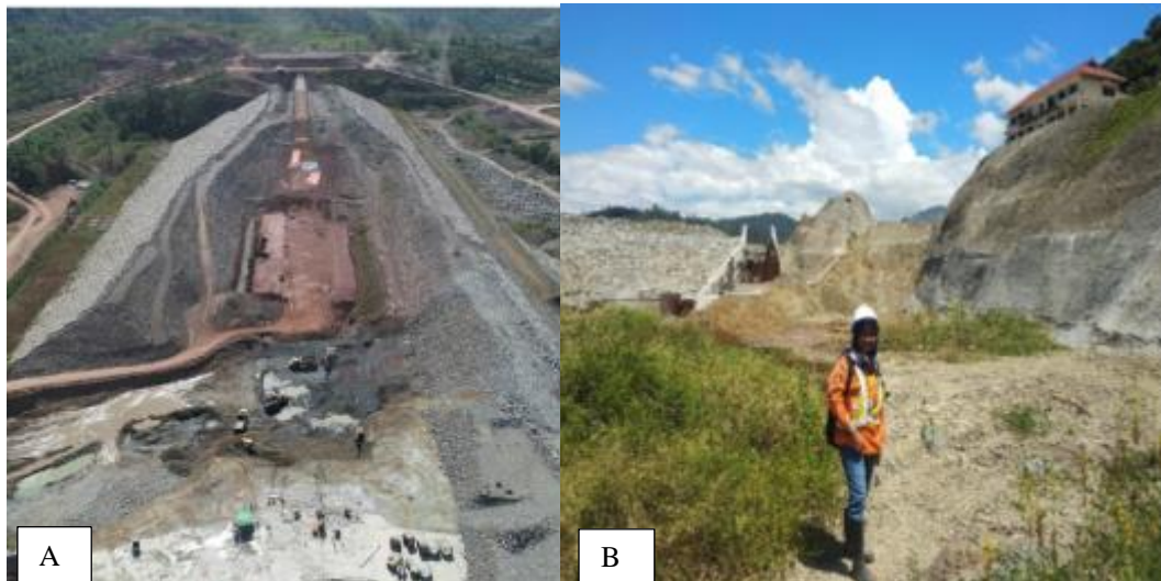
Gambar 1.3 (A) Situasi pengerjaan pembangunan bendungan (B) Lokasi pembangunan Bendungan Lolak
