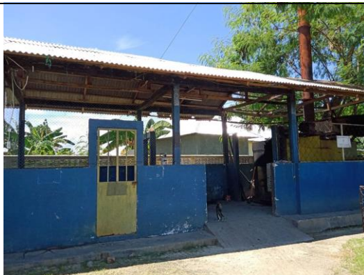
Gambar 29. Gedung tempat pembakaran limbah (Insenerator)
